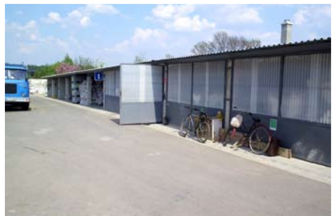
Priestory na Zbernom dvore, kde sa dotriedkujú, lisujú a skladujú vyseparované odpady
